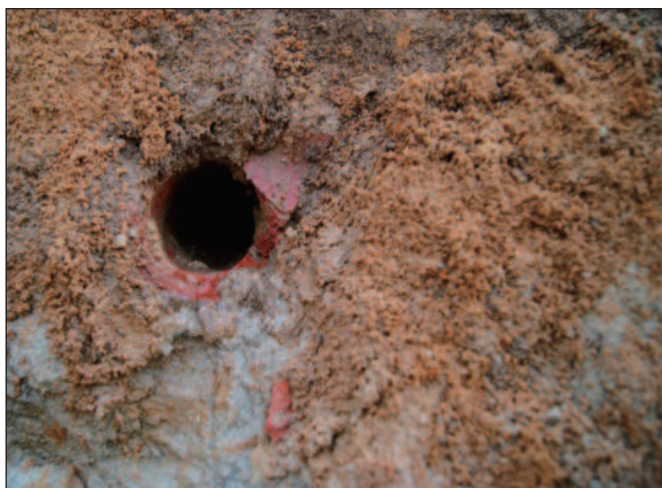
Jedna z přetržených a nenapojených drenáží ...
